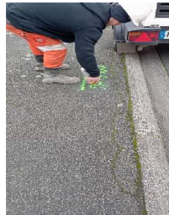
Figure 18 Traçage des réseaux
