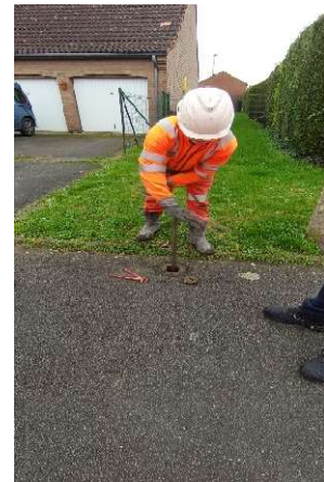
Figure 23 Fermeture du réseau avec une clé de fontainier
