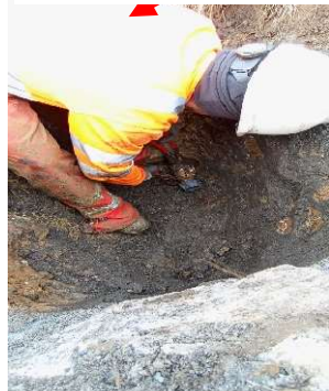
Figure 24 Raccordement de la nouvelle vanne au réseau (flexion du tronc)
