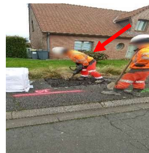
Figure 20 Ouvverture de l'enrobé avec effort de poussée
